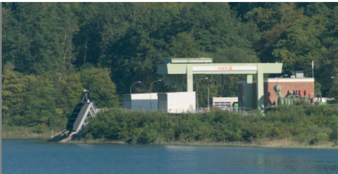
Krafthaus am Unterbecken
